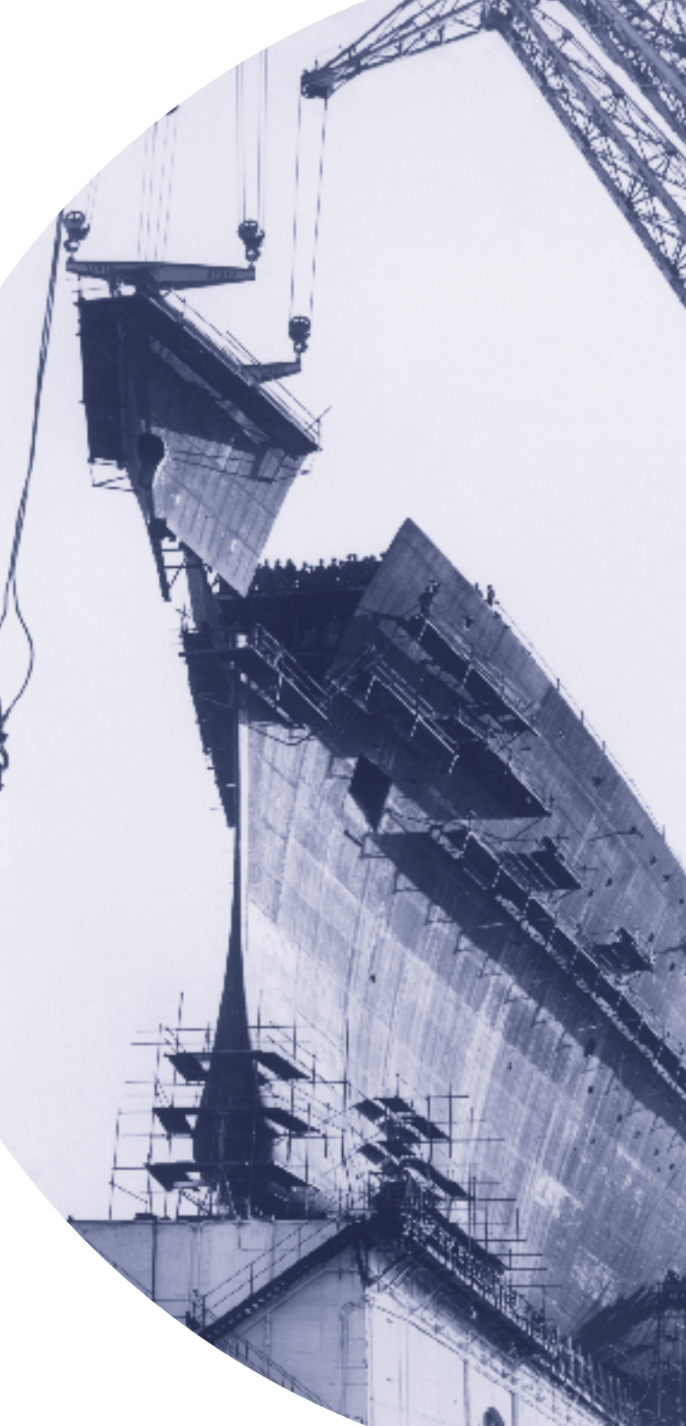
< Pose du dernier élément d'étrave du paquebot France (CGT 1962-1977), le 24 novembre 1959
