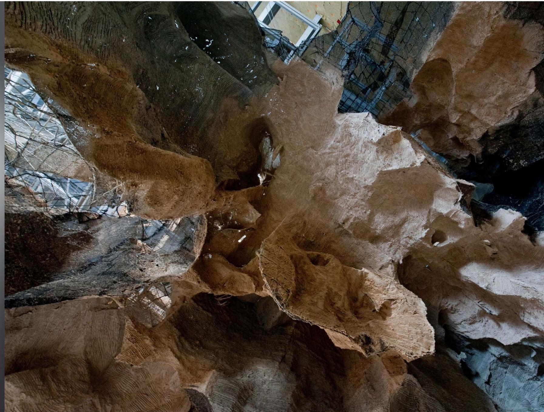
Construction en métal et béton de la structure de la caverne
